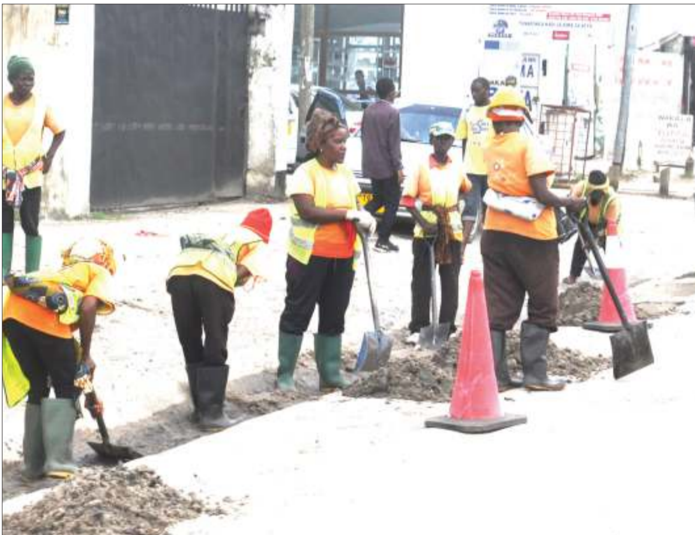
Wafanyausafi wakiondoa mchanga kwenye mitaro ya maji ya mvua kando ya Barabara ya Uhuru, eneo la Ilala Bungoni, jijini Dar es Salaam jana. Picha: JOHN BADI
