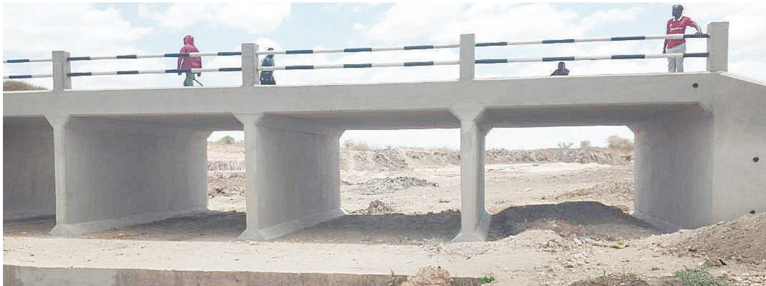
Moja ya madaraja yanayojengwa mkoani Manyara. Picha: JALIWASON JASSON
