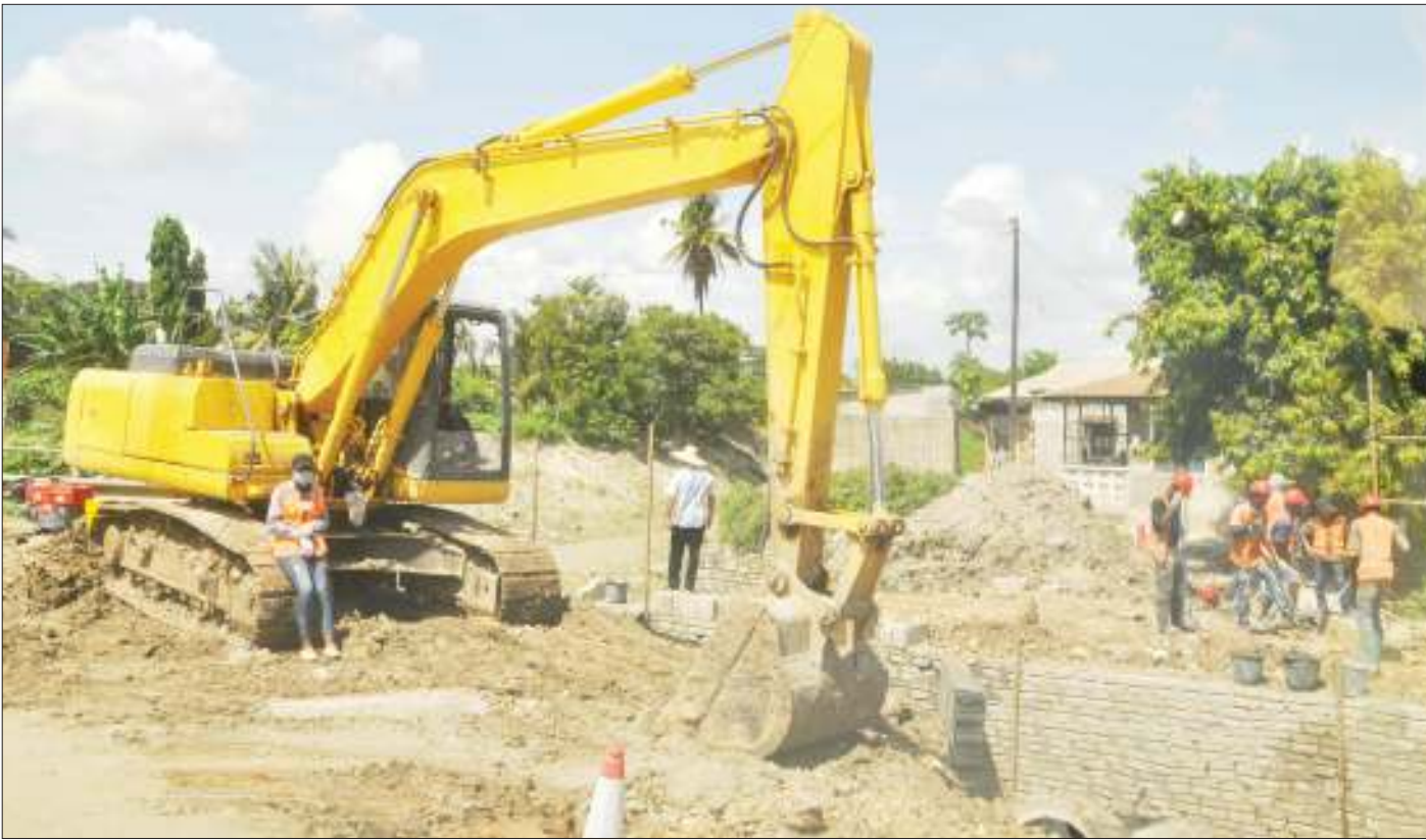
Mafundi wa kampuni ya CRSG, wakiendelea na ujenzi wa barabara inayounganisha eneo la Kijitonyama na Sinza Uzuri, jijini Dar es Salaam jana. PICHA: JOHN BADI
