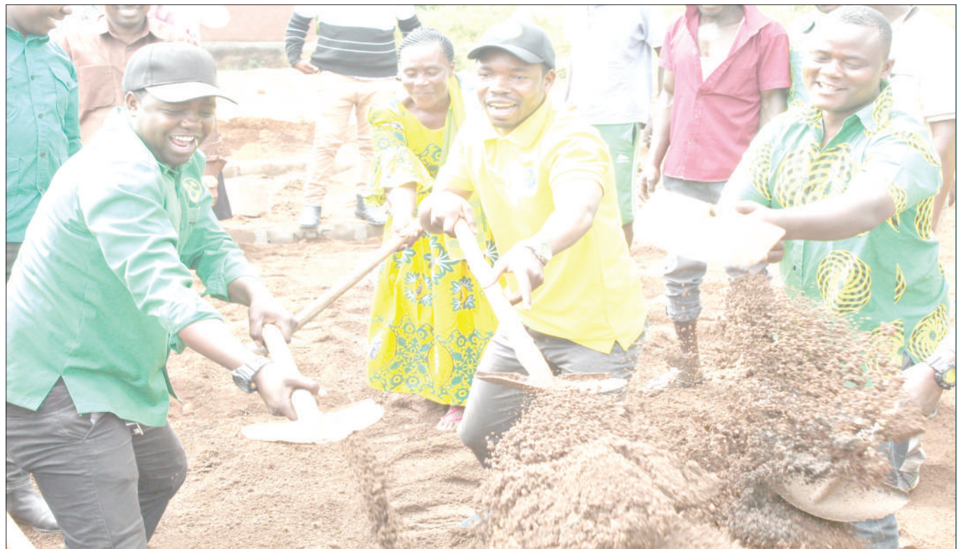
Naibu Waziri wa Nchi Ofisi ya Waziri Mkuu, Kazi, Vijana na Ajira, Patrobas Katambi ambaye ni Mbunge wa Jimbo la Shinyanga Mjini (katikati), akishiriki na wananchi ujenzi wa vyumba vya madarasa kwa kusawazisha mchanga, katika shule ya Msingi Mlimani iliyopo Oldshinyanga, jana, PICHA: MARCO MADUHU
