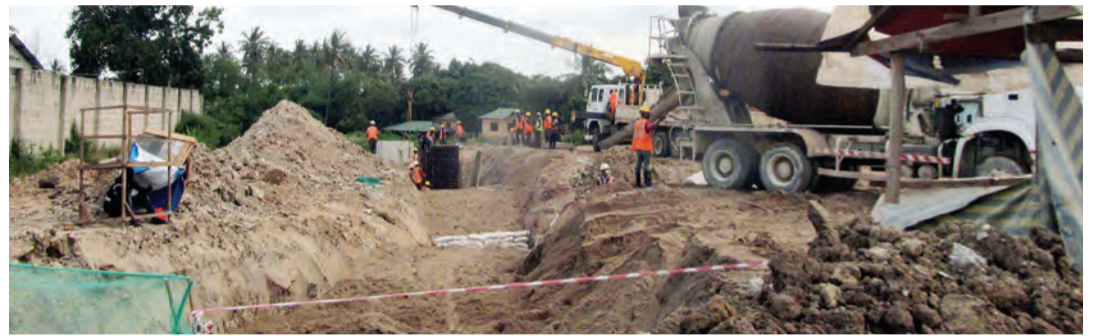
Mafundi wakitengeneza mtaro wa maji ya mvua pembeni mwa barabara inayoelekea kituo cha daladala cha Mawasiliano, jijini Dar es Salaam juu. PICHA: SABATO KASIKA
