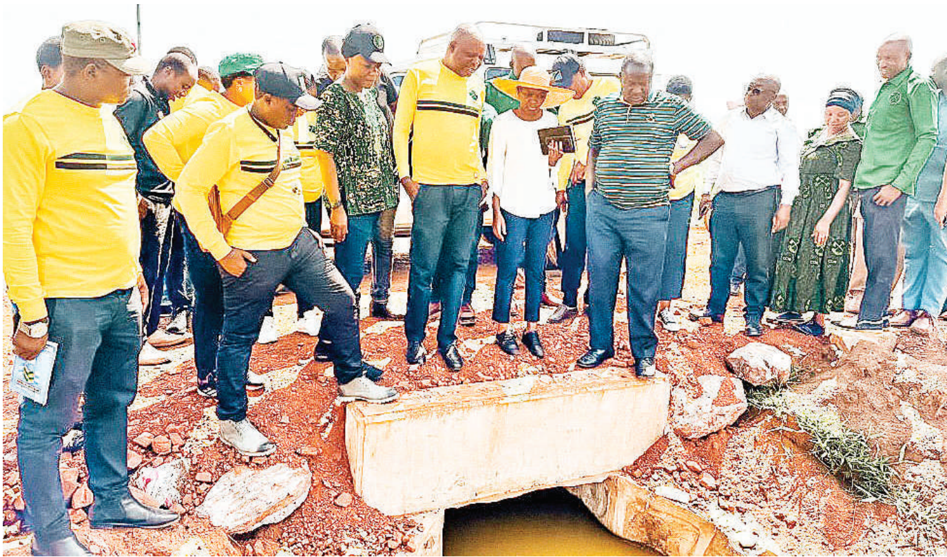
Wajumbe wa Kamati ya Siasa ya CCM Mkoa wa Shinyanga wakiongozwa na Mwenyekiti wa CCM Mkoa, Mabala Mlola wakikagua ujenzi wa miundombinu ya barabara na madaraja katika barabara ya Mwakitolio hadi Nyang'ombe wilayani Shinyanga juzi. PICHA: MARCO MADUHU
