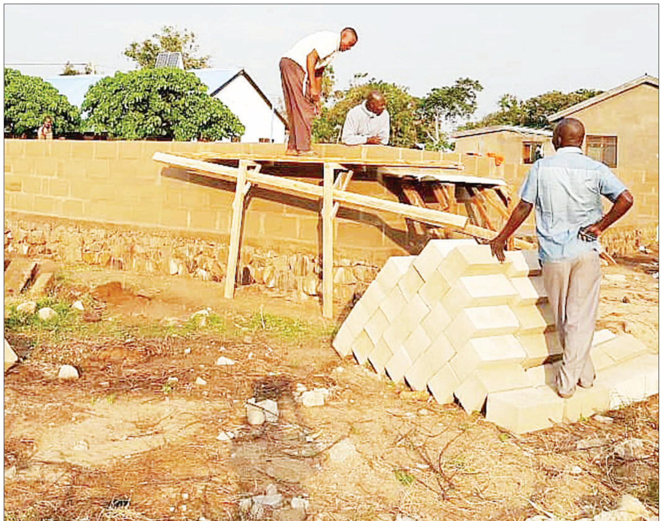
Mafundi wakiendelea na ujenzi wa wodi ya mama na mtoto katika Zahanati ya Kisiwa cha Rukuba, Musoma Vijijini mkoani Mara juzi, ikiwa ni uboreshaji wa huduma za afya. PICHA: MPIGA PICHA WETU
