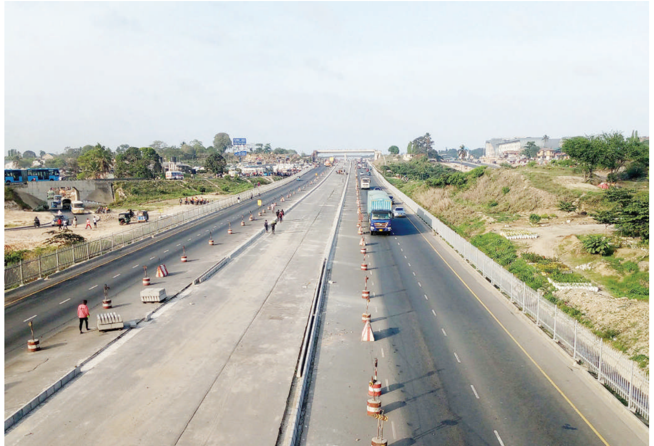
Mwonekano wa Barabara ya Morogoro eneo la Mbezi Luis baada ya kuwekewa uzio pembeni, ili waenda kwa miguu wapite juu ya daraja. PICHA: SABATO KASIKA
