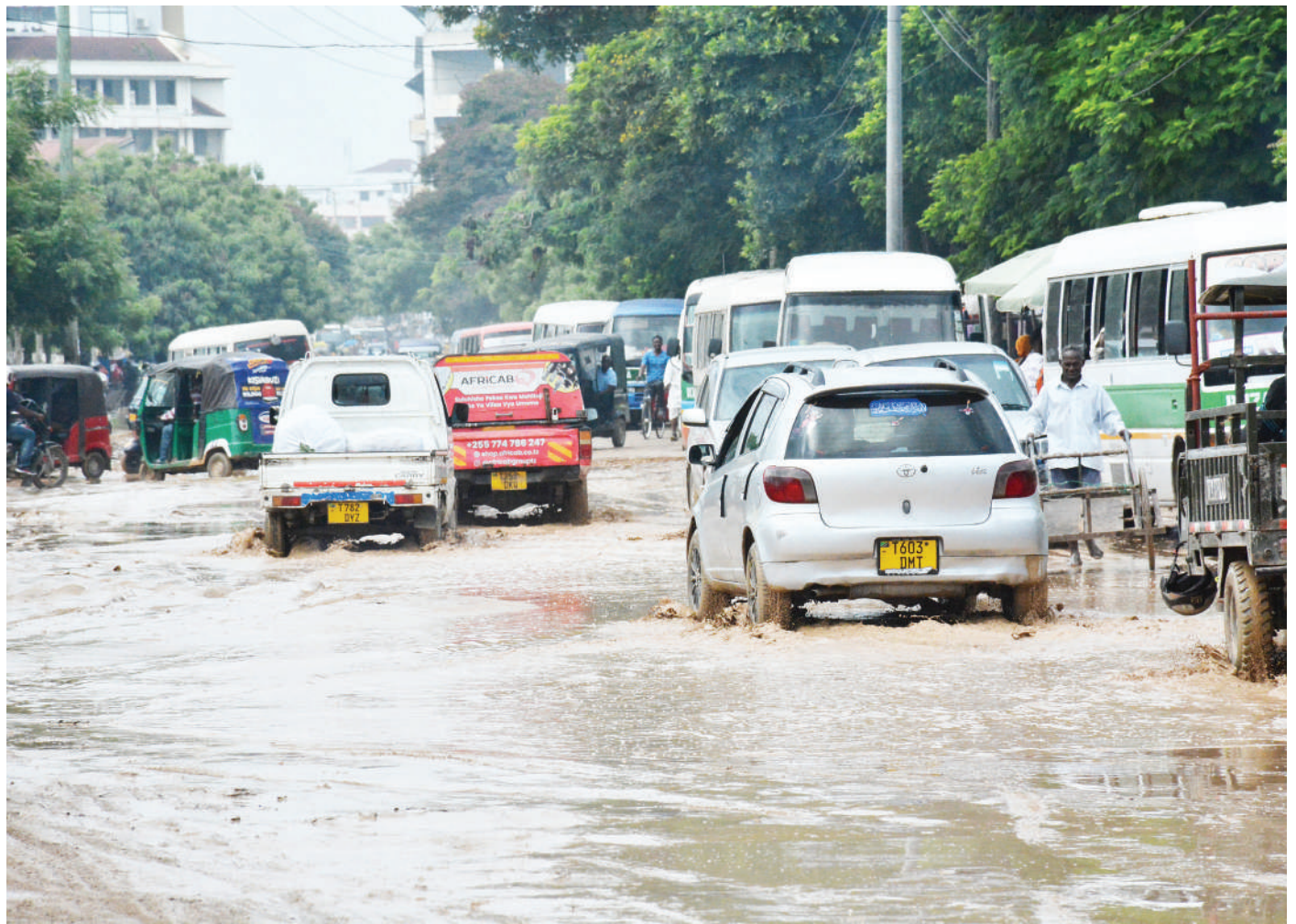
Vyombo vya moto vikipita kwa shida na kusababisha foleni kutokana na maji ya mvua yaliyotuma katika barabara ya Mtaa wa Lindi na Msimbazi, jijini Dar es Salaam jana. PICHA: MIRAJI MSALA
