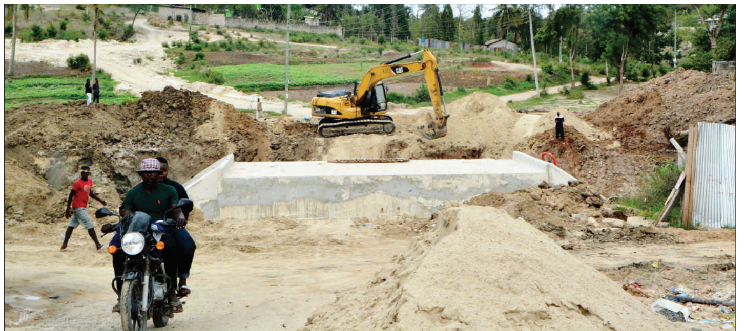
Mafundi wakiendelea na ujenzi wa daraja linalounganisha eneo la Mbezi Louis na Kitongoji cha Mshikamano katika Mto Mbezi, Manispaa ya Ubungo, mkoani Dar es Salaam jana, litakalopunguza usumbufu kwa wananchi hasa nyakati za mvua. PICHA: MIRAJI MSALA
