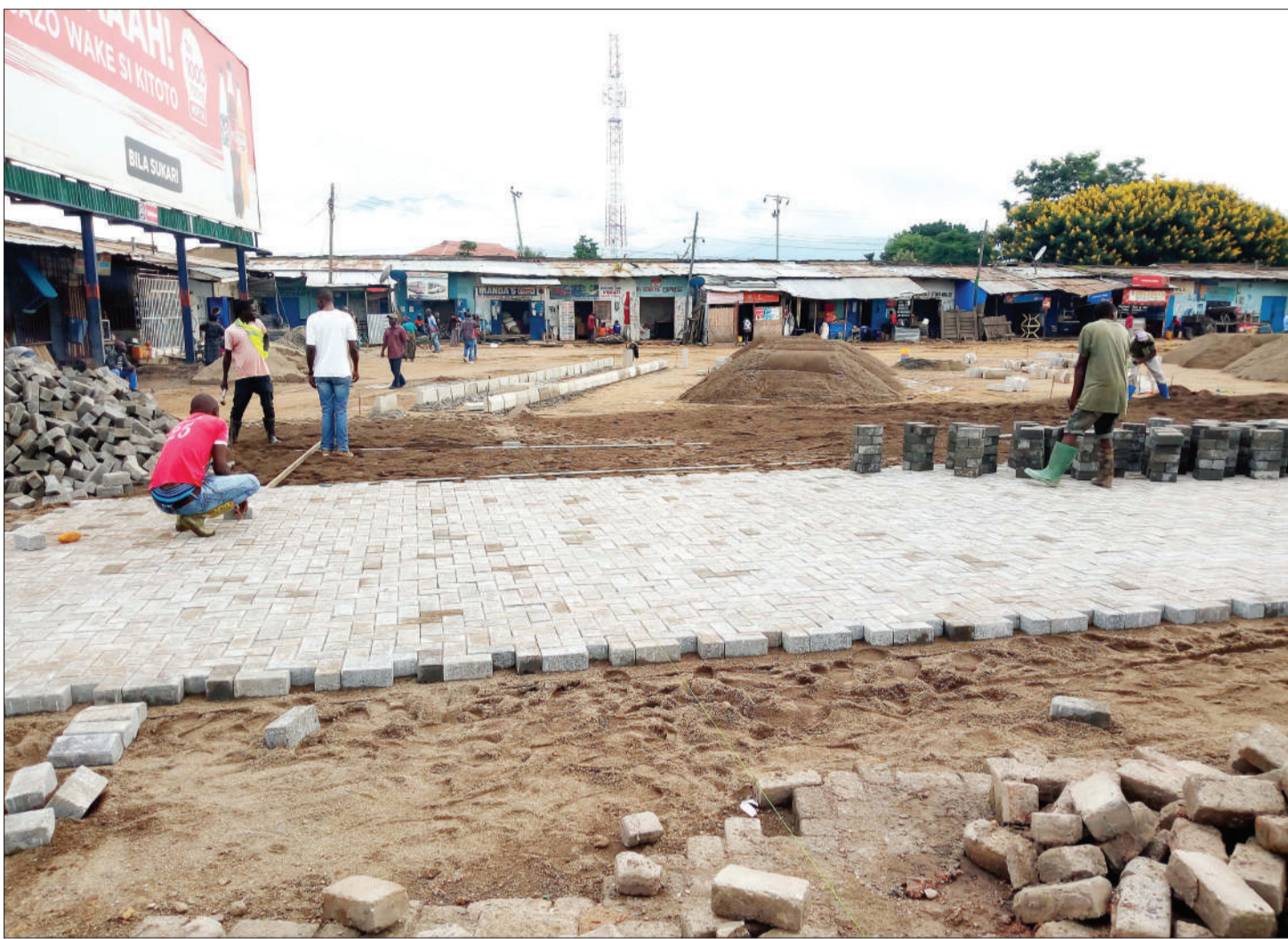
Mafundi wakiendelea na ujenzi wa stendi ya mabasi ya Tarafani katika Mamlaka ya Mji Mdogo wa Mbalizi mkoani Mbeya ambayo ilikuwa imetelekezwa muda mrefu na kusababisha adha kwa watumiaji kutokana na kujaa maji mara kwa mara. PICHA: NEBART MSOKWA
