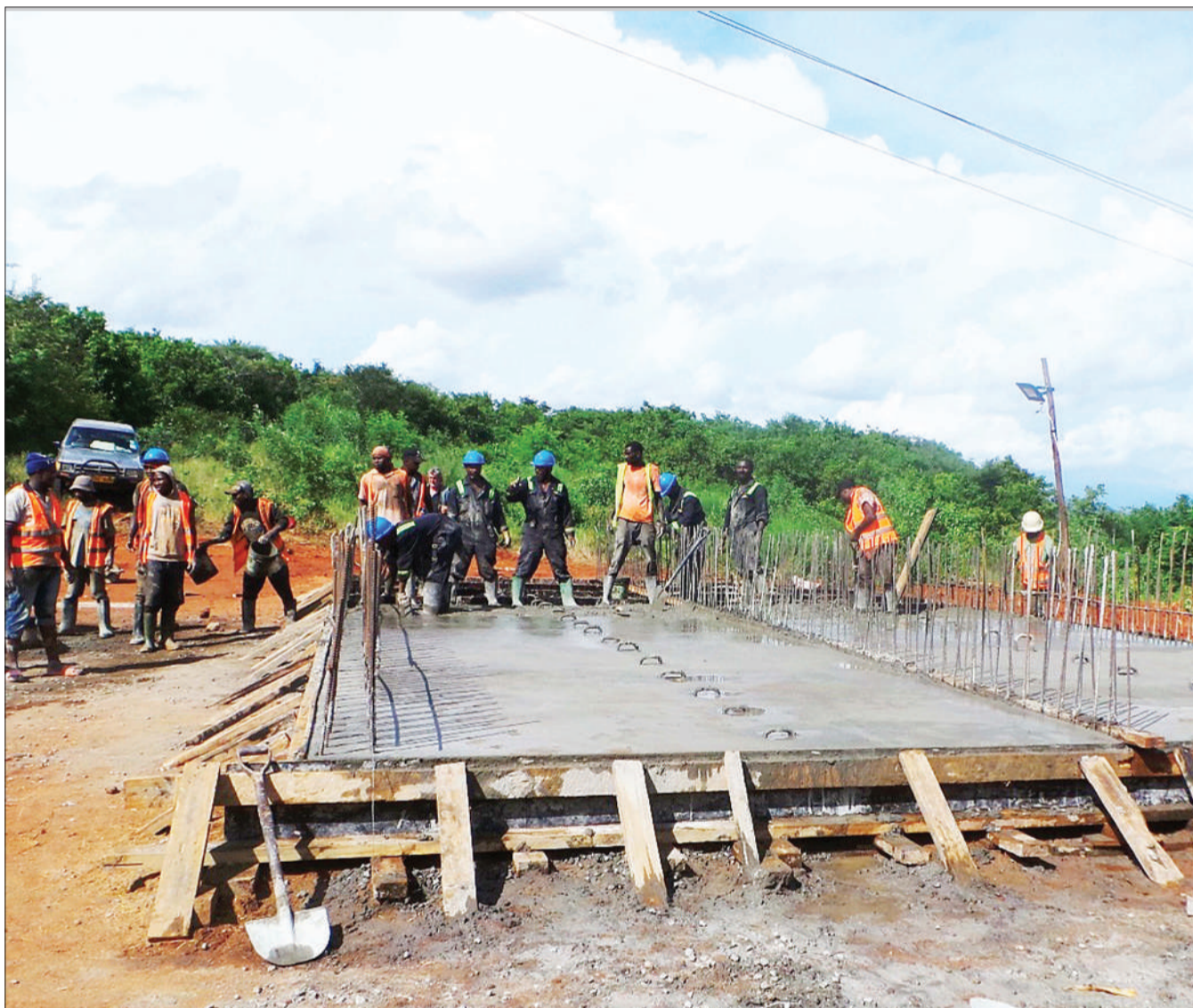
Wafanyakazi wanaojenga daraja la Kiyegeya lililopo mkoani Morogoro, wakiwa katika maandalizi ya ujenzi wa daraja hilo, lililokuwa limezolewa na maji ya mvua. PICHA: WUU
