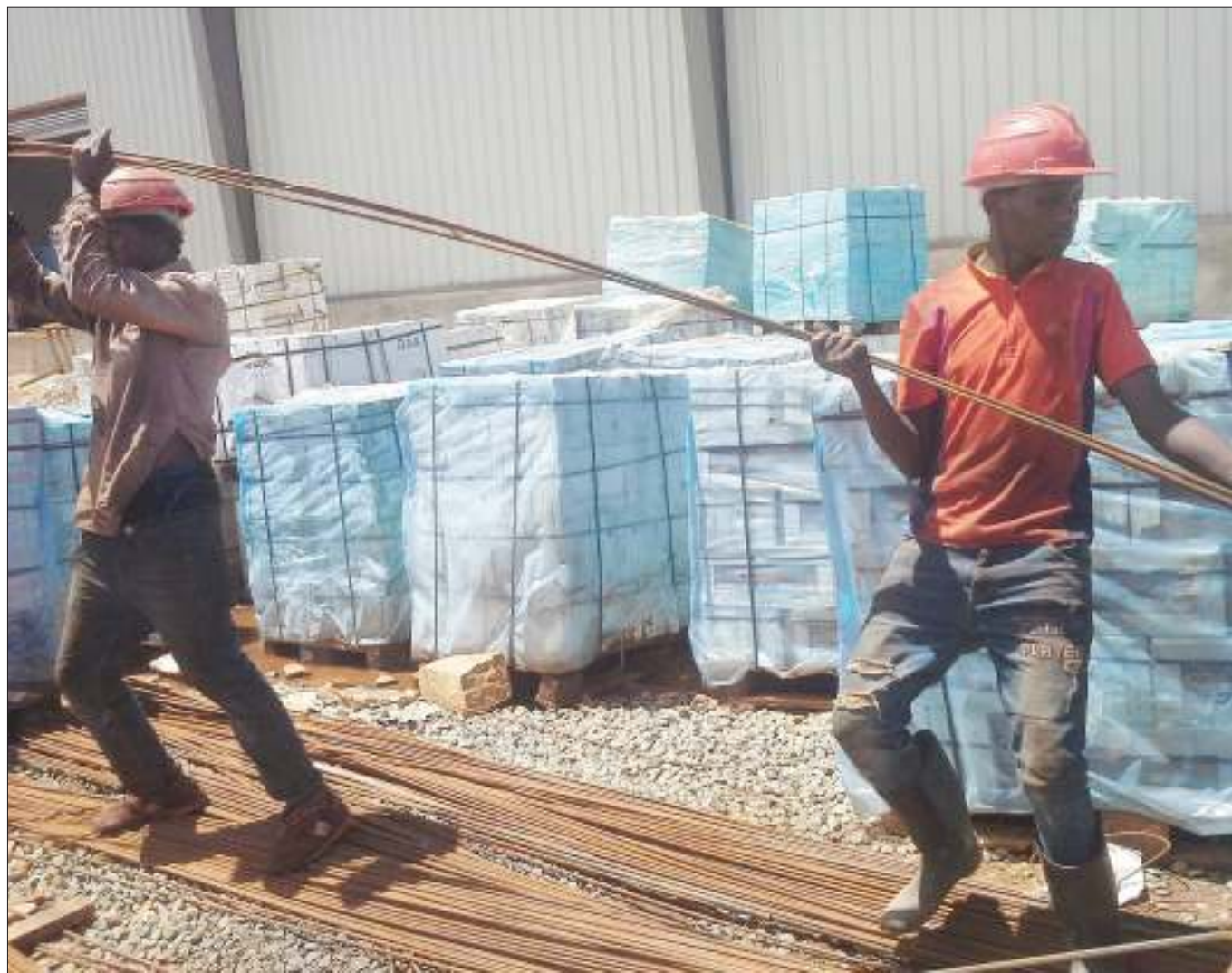
Paulo Martin na Issa Shaban wakilinganisha vyuma ili kuvisuka kwa ajili ya kumimina zege kwenye moja ya jengo la uzalishaji la kiwanda cha kusindika nyama cha (ELIYA), kinachoendelea kujengwa wilayani Longido eneo la mpaka wa Namanga chenye uwezo wa kusindika mbuzi na kondoo 3,000 hadi 4,000 kwa siku na ng'ombe 500 kwa ajili ya soko la nje hasa Kenya. PICHA: DANIEL SABUNI
