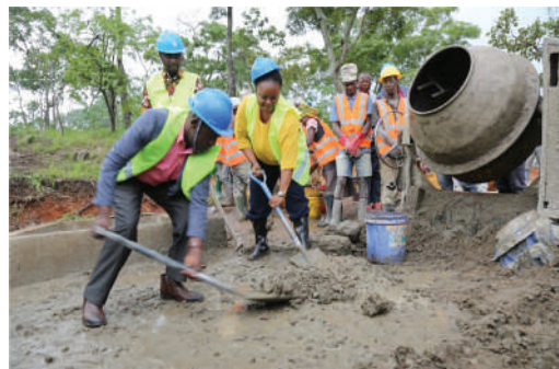
Naibu Waziri wa Maji Mhe. Mhandisi Maryprisca Mahundi (Mb) akijumuika na wataalam wa ufundi katika kuchanganywa udongo wa ujenzi (Zege) katika moja ya mradi wa maji hivi karibuni.
