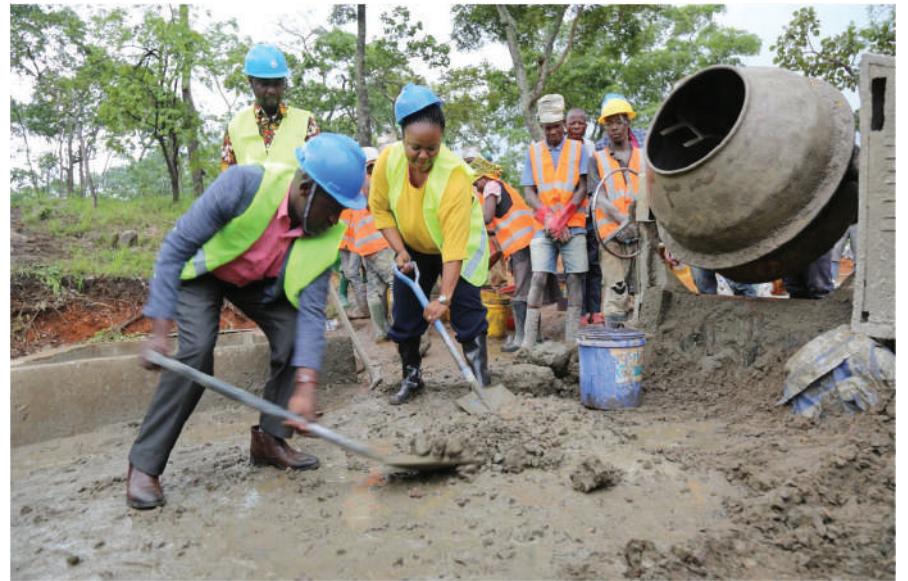
Naibu Waziri wa Maji Mhe. Mhandisi Maryprisca Mahundi (Mb) akijumuika na wataalam wa ufundi katika kuchanganganya udongo wa ujenzi (Zege) katika moja ya mradi wa maji hivi karibuni.
