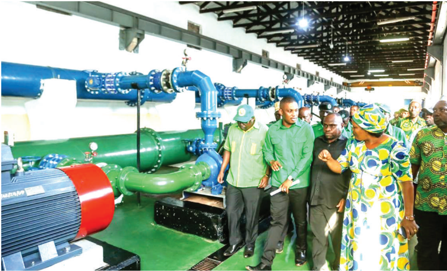
Katibu wa NEC, Itikadi na Uenezi, Shaka Hamdu Shaka (wapili kushoto), na viongozi wengine wa CCM, wakikagua mradi wa maji wa Ziwa Tanganyika. PICHA: BEATRICE SHAYO
