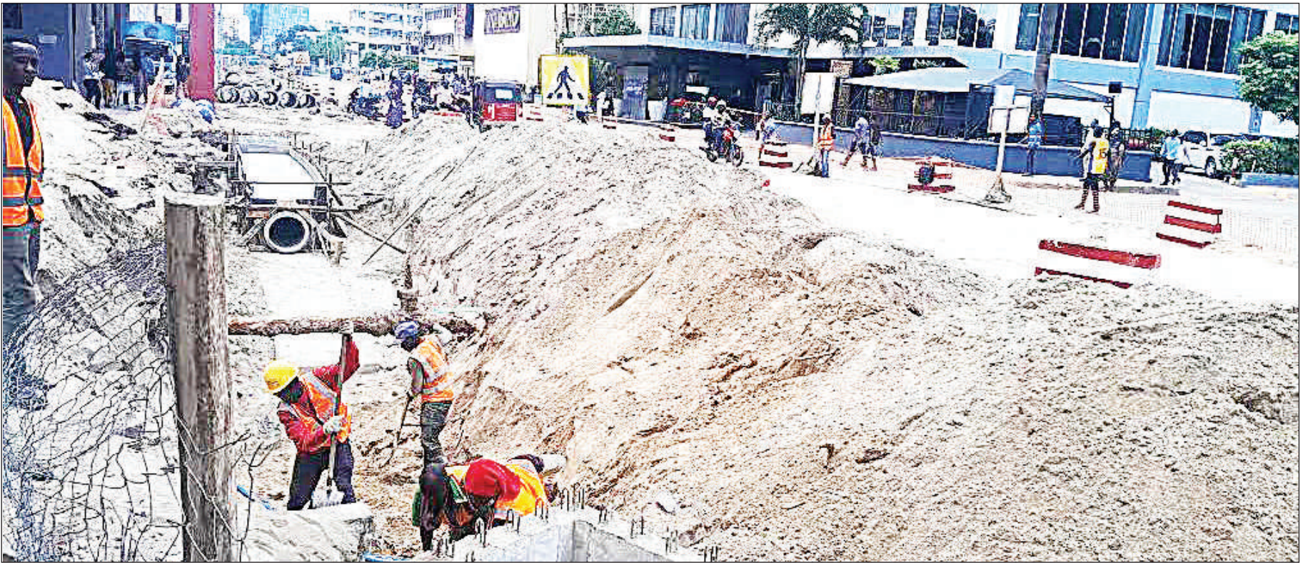
Mafundi wa mkandarasi wakitengeneza miundombinu ya maji ya mvua katika ujenzi unaoendelea wa barabara ya m basi yaendayo haraka katika Mtaa wa Azikiwe, katikati ya Jiji la Dar es Salaam jana. PICHA: IMANI NATHANIEL
