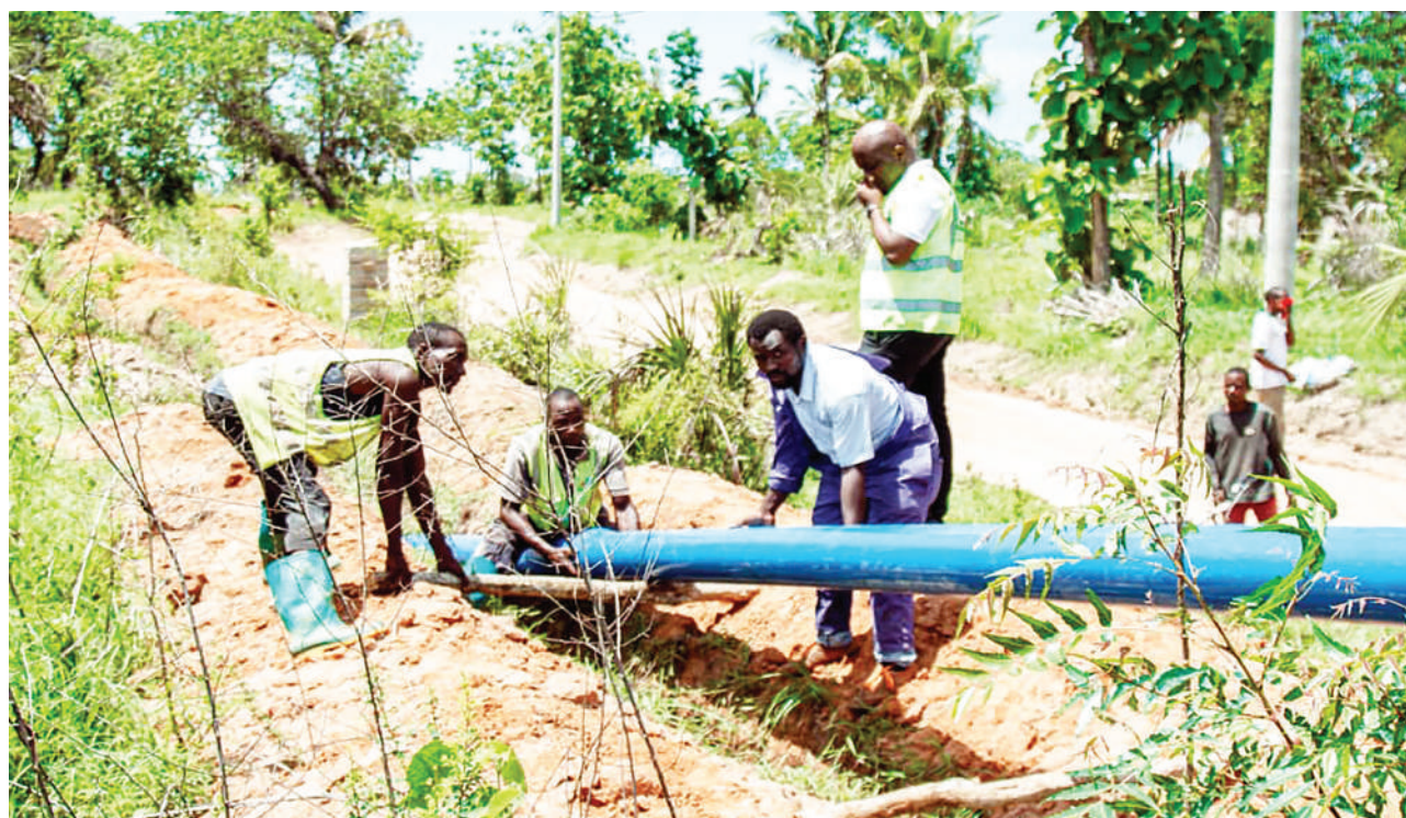
Mafundi wa Mamlaka ya Maji na Usafi wa Mazingira (DAWASA), wakiweka mabomba kwenye mradi wa Mbopo Chekanao, Kata ya Mabwepande, Manispaa ya Kinondoni, Dar es Salaam juzi. PICHA: JOSEPH MWENDAPOLE
