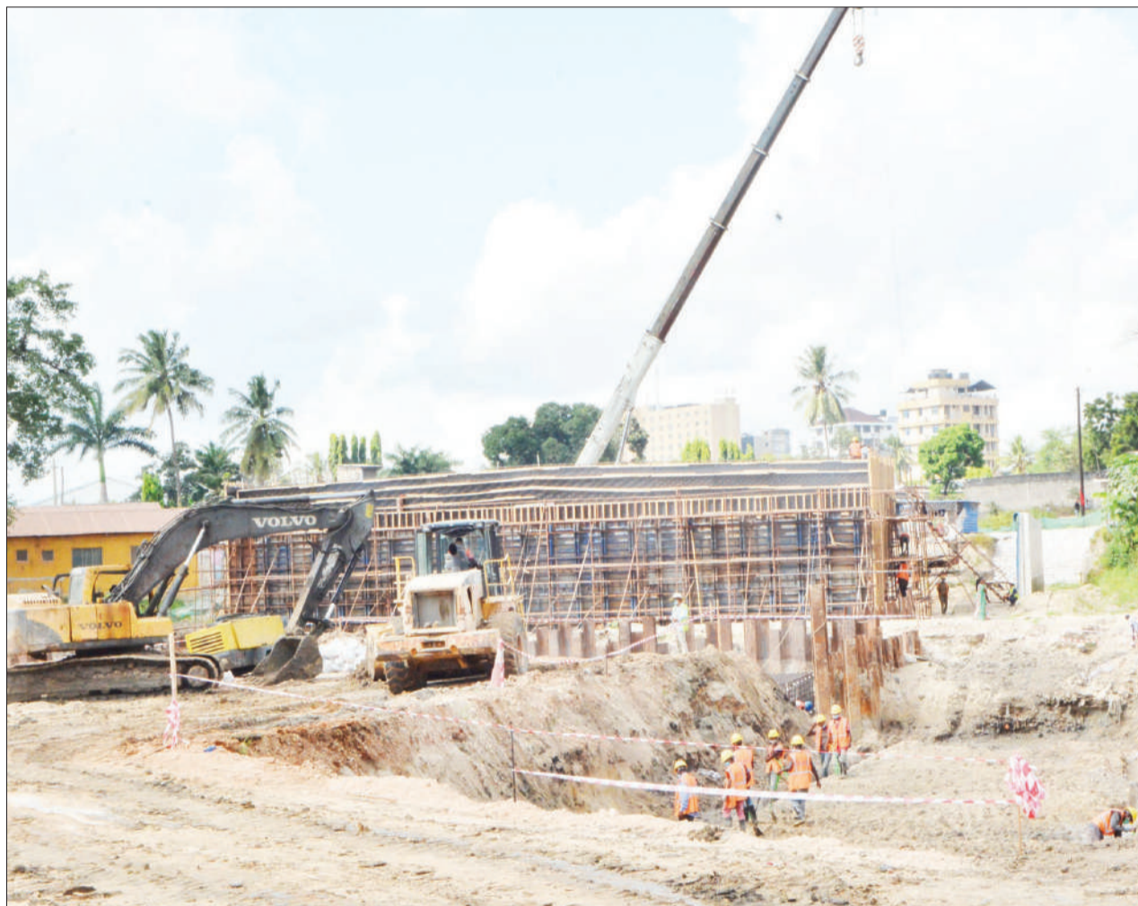
Maofundi wakiendelea na ujenzi wa daraja litakalounganisha eneo la Ubungo na kituo cha daladala cha Mawasiliano, jijini Dar es Salaam mwishoni mwa wiki. PICHA: MIRAJI MSALA
