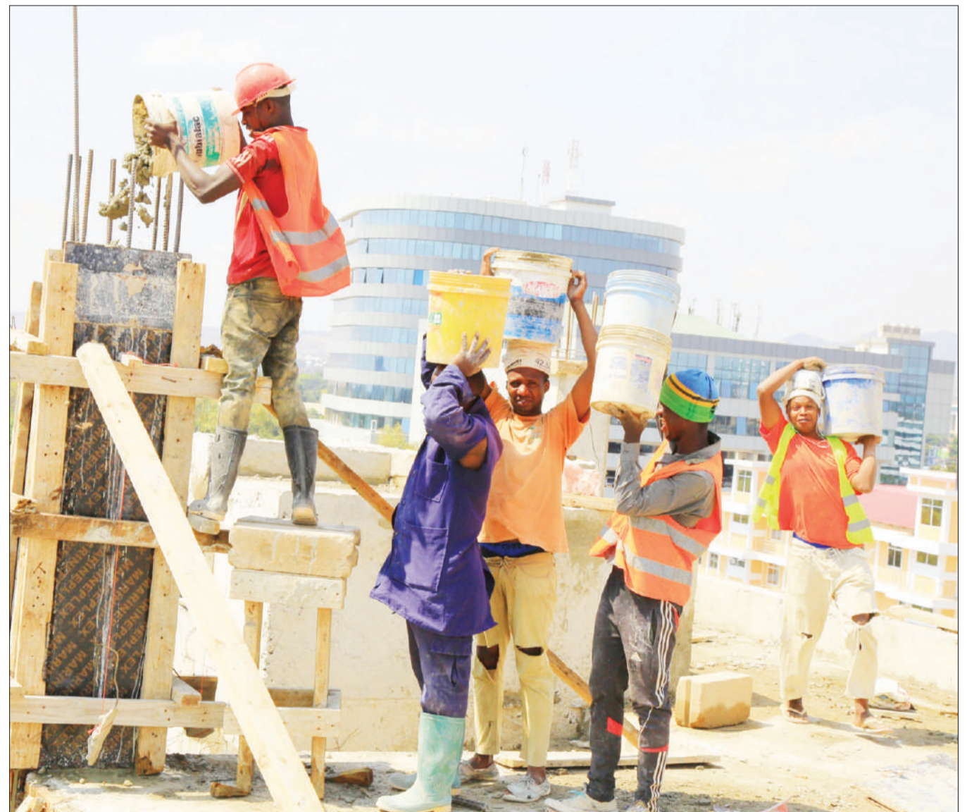
Mafundi wakiendelea na ujenzi wa jengo eneo la katikati ya Jiji la Dodoma jana. Tangu serikali kuhamishia makao makuu yake jijini humo, uwekezaji wa majengo makubwa umekuwa ukifanyika kwa kasi kubwa zaidi. PICHA: IBRAHIM JOSEPH
