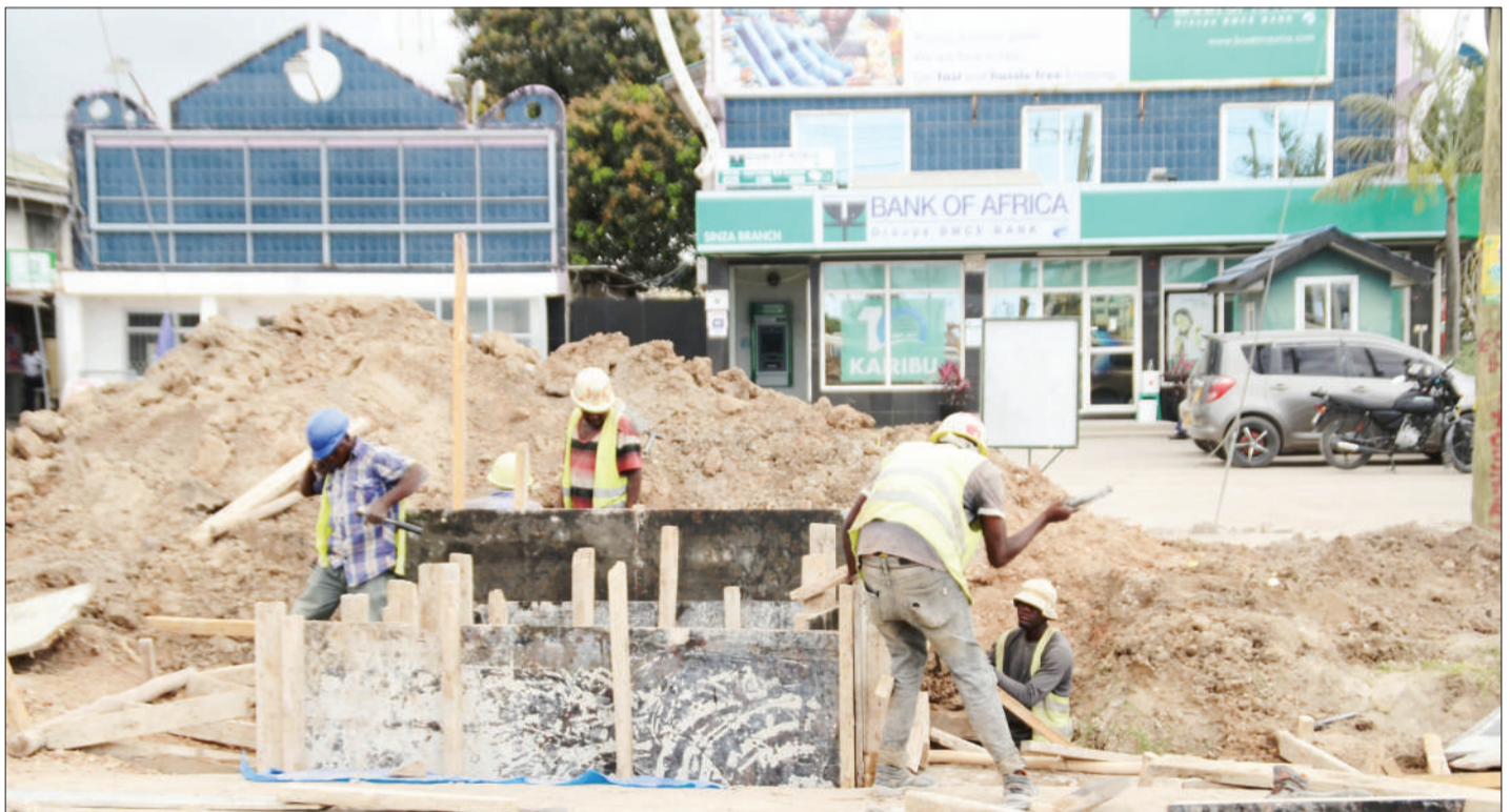
Mafundi ujenzi wakijenga chemba ya maji taka katika ujenzi unaoendelea wa barabara ya Shekilango, eneo la Sinza, jijini Dar es Salaam jana.
