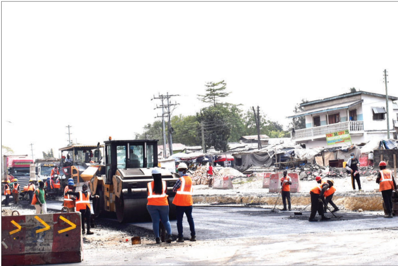
Mafundi wa CCECC, wakiendelea na upanuzi wa barabara katika makutano ya barabara ya Morogoro na Sam Nujoma, eneo la Ubungo, jijini Dar es Salaam jana. Picha: MARIAM MAGILI
