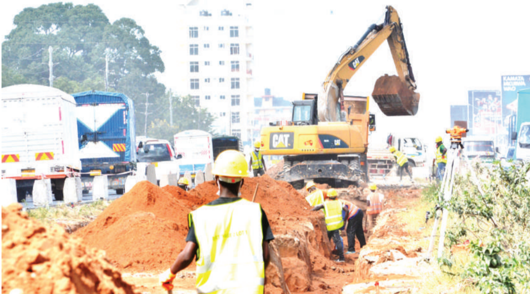
Mafundi wa kampuni ya ukandarasi wakiendelea na kazi ya ujenzi wa miundombinu ya barabara ya mabasi ya mwendokasi, katika eneo la Mbagala Kizuiani, jijini Dar es Salaam jana. PICHA: MIRAJI MSALA
