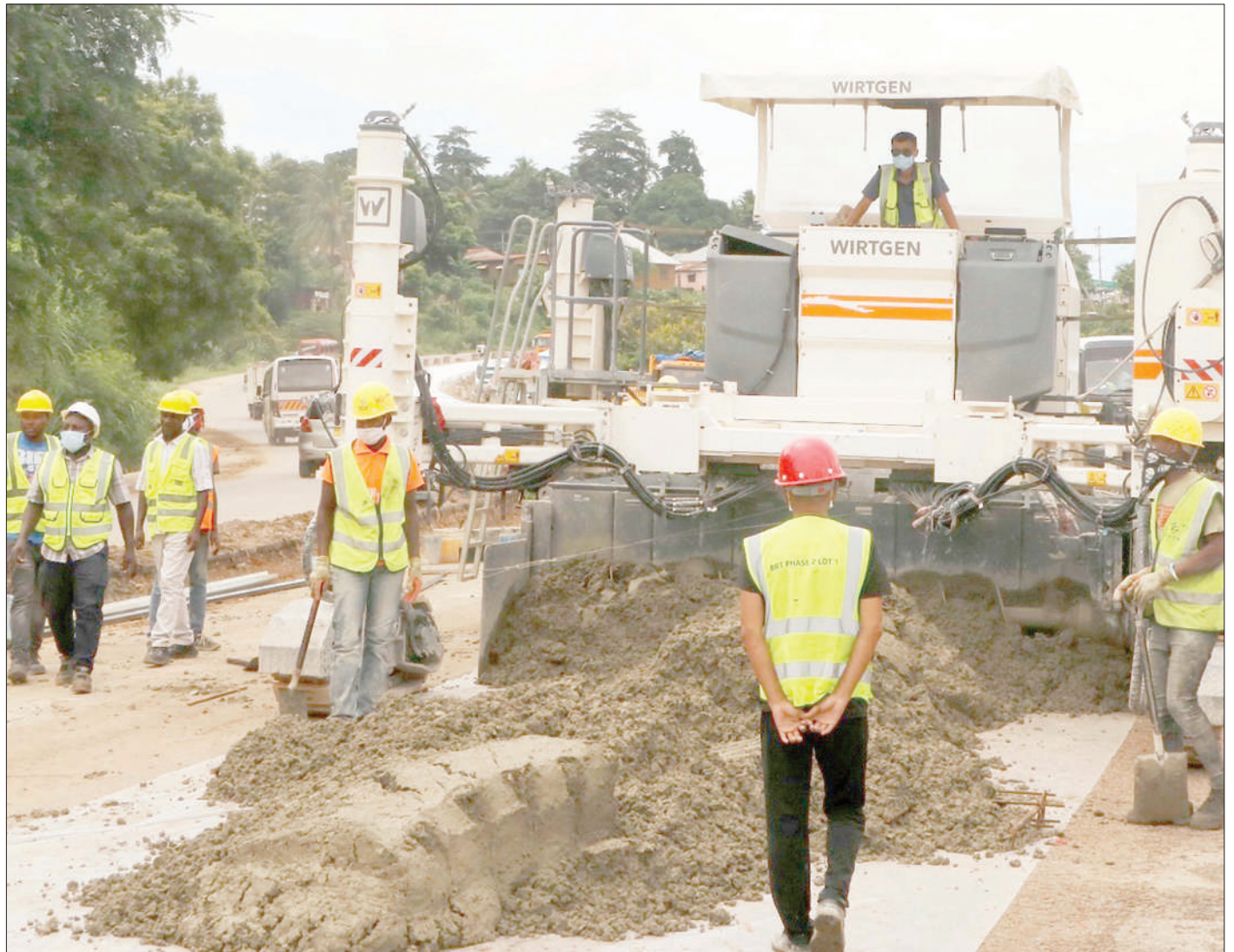
Mafundi wakiendelea na ujenzi wa miundombinu ya mabasi ya mwendokasi kuanzia Mbagala hadi Gerezani, katika eneo la Kurasini, barabara ya Kilwa, jijini Dar es Salaam jana. PICHA: JUMANNE JUMA
