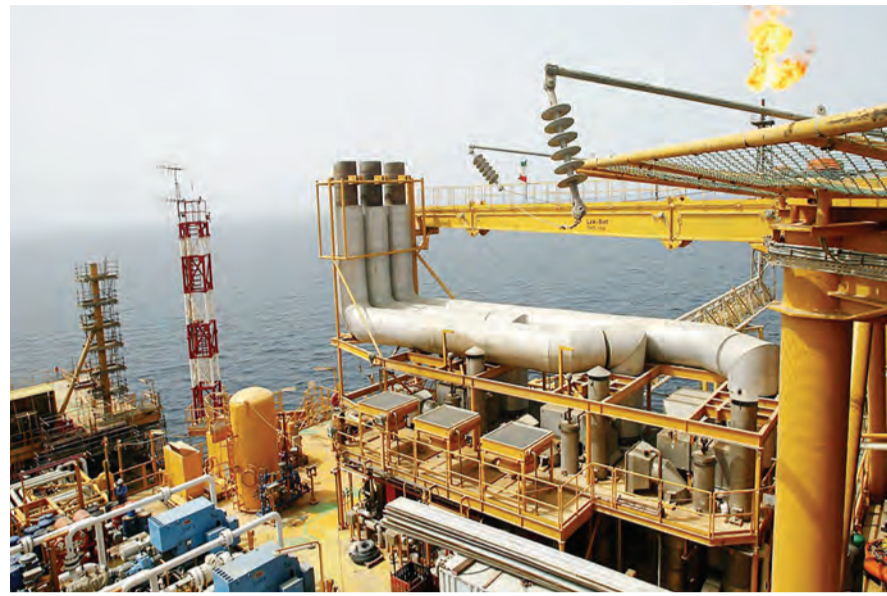
LNG plant in Saudi Arabia
