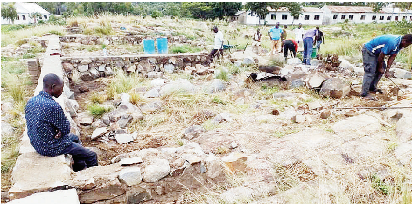
Maifundi wakiendelea na ujenzi wa msingi wa madarasa ya sekondari mpya ya Kisiwa cha Rubuka, jimbo la Musoma Vijijini, mkoani Mara jana. PICHA: MPIGAPICHA WETU
