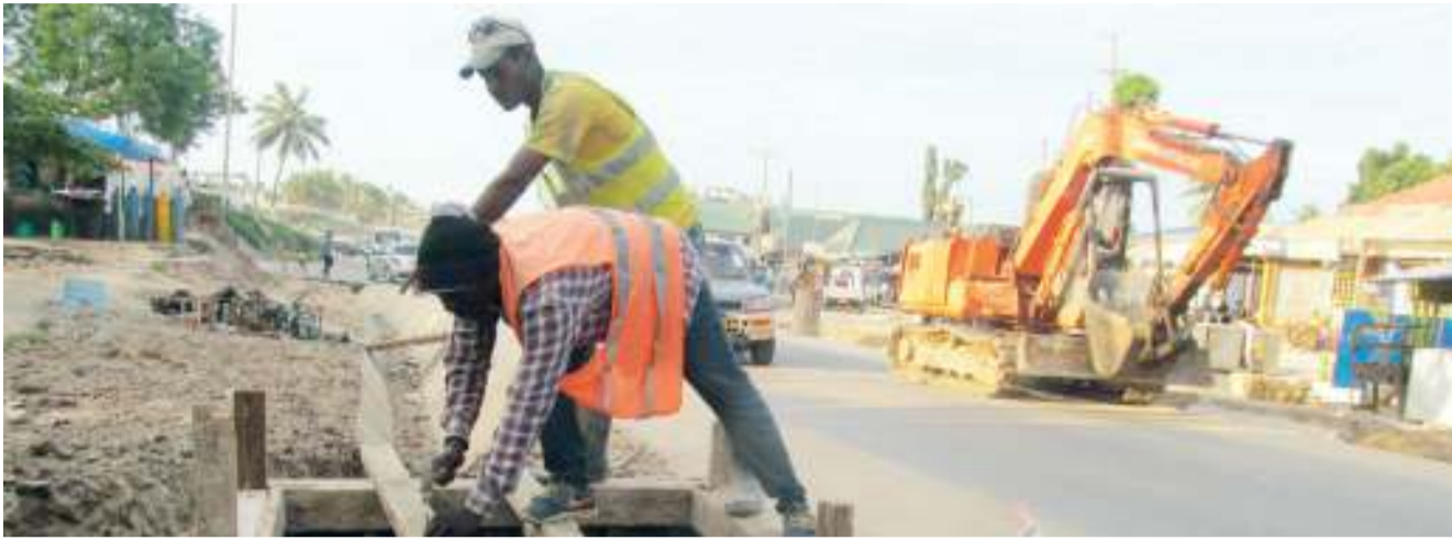
Mafundi wakiendelea na kazi ya uboreshaji wa mitaro ya maji ya mvua katika Barabara ya Malamba Mawili, eneo la Mbezi Mwisho, jijini Dar es Salaam jana. PICHA: SABATO KASIKA.
