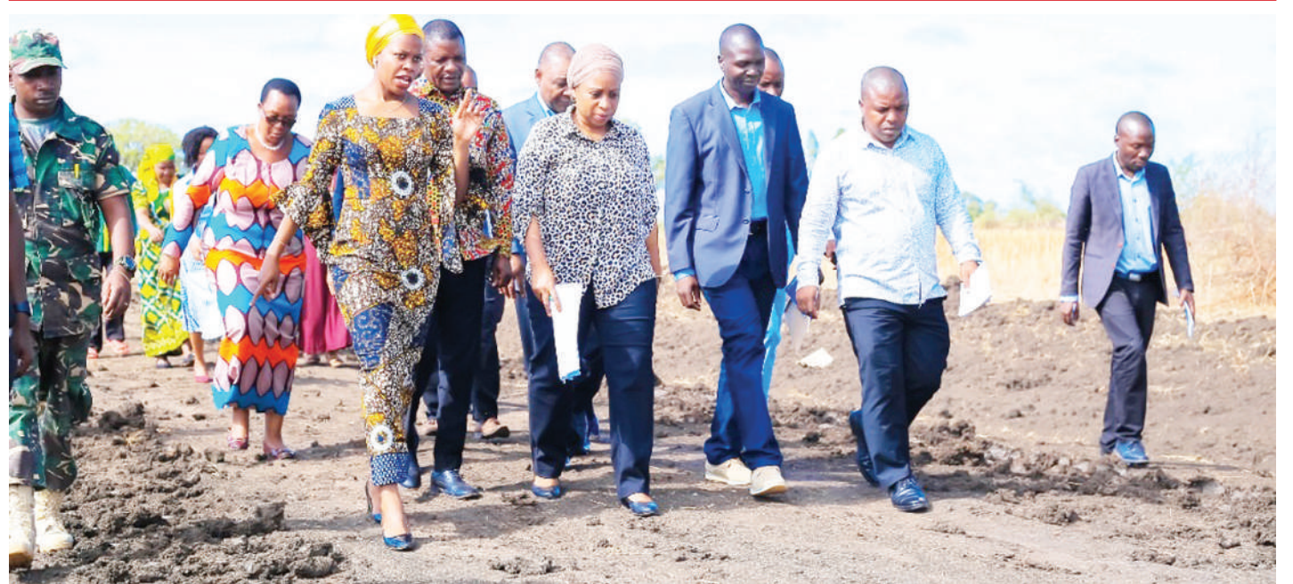
Waziri wa Nchi Ofisi ya Rais Tawala za Mikoa na Serikali za Mitaa (TAMISEMI) Umyy Mwalimu akiwa na baadhi ya viongozi wa wilaya ya Iramba mkoani Singida akikagua ujenzi wa barabara ya Shelui - Tintigulu yenye urefu wa kilomita saba inayojengwa kwa kiwango cha lami na wakala wa barabara mijini na vijijini TARURA. Picha Paul Mabeja
