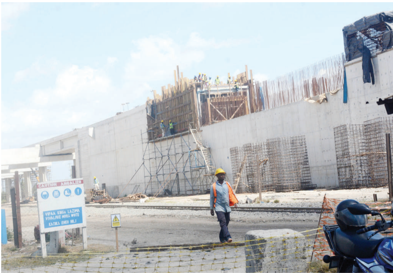
Mafundi wakiendelea na ujenzi wa reli ya treni ya kisasa (SGR), katika eneo la Tazara, jijini Dar es Salaam jana. PICHA: TUKUSUMA MWANDEMELELA - TUDARCO
