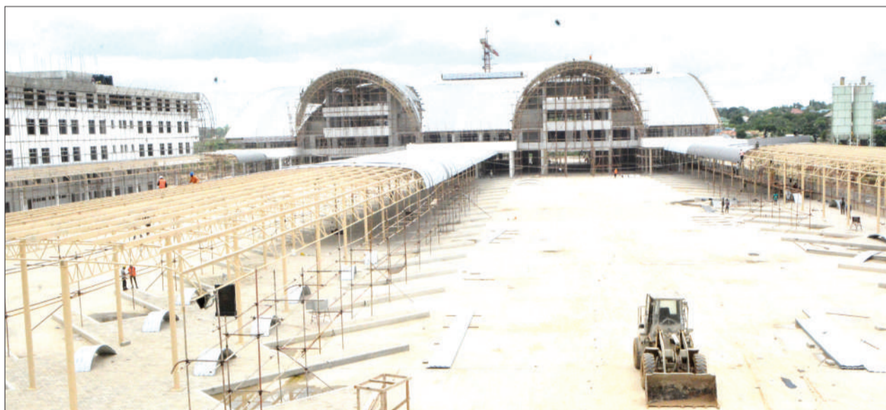
Mwonekano wa stendi mpya ya mabasi ya mikoani inayoendelea kujengwa katika eneo la Mbezi Mwisho, jijini Dar es Salaam jana. PICHA: MIRAJI MSALA
