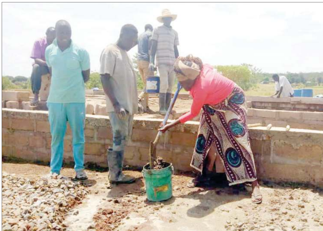
Mjumbe wa kamati ya ujenzi sekondari mpya ya vijijini vya Kigera Etuma na Kakisheru, Musoma Vijijini, mkoani Mara, Stella Majira, akishiriki katika kuandaa saruji kwa ajili ujenzi wa msingi wa madarasa ya shule hiyo jana. NA MPIGAPICHA WETU
