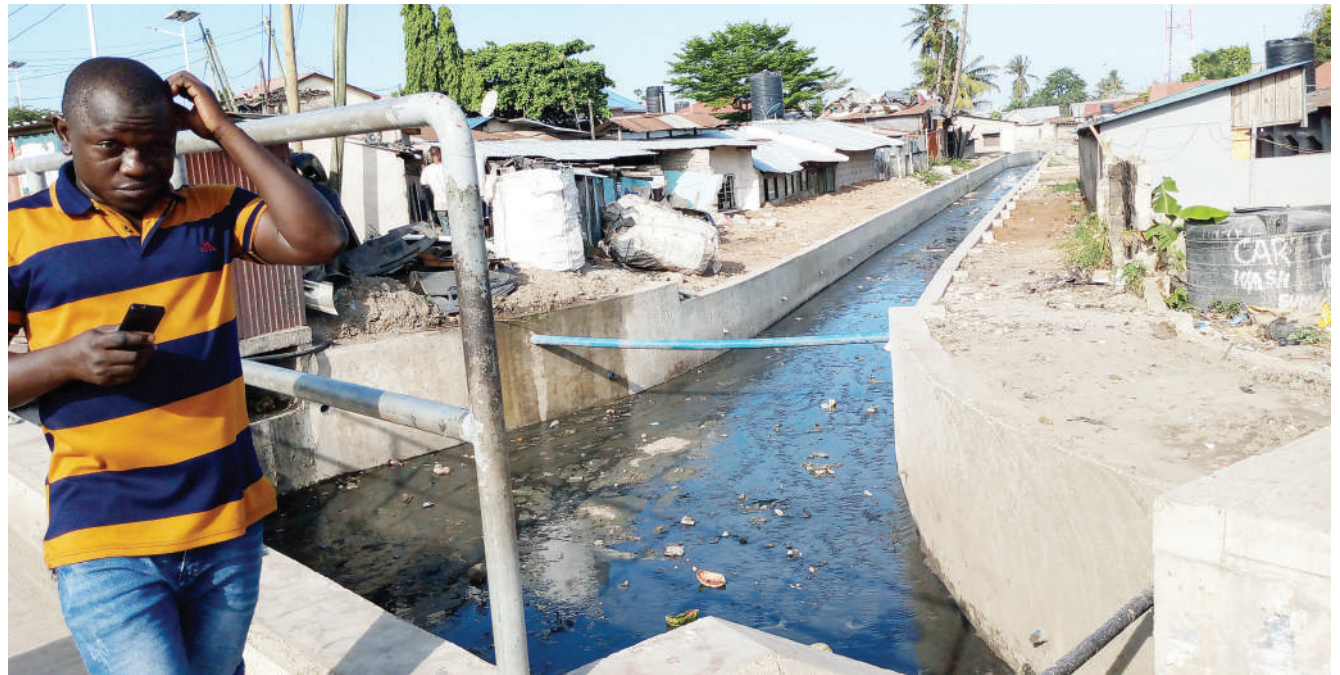
Mtaro uliojengwa kwa ajili ya kupitisha maji ya mvua eneo la Kilimani Manzese Dar es Salaam ukiwa umejaa majitaka baada ya wakazi wa eneo hilo kudaiwa kuchepusha maji ya vyooni kwenye mtaro huo. PICHA: SABATO KASIKA
