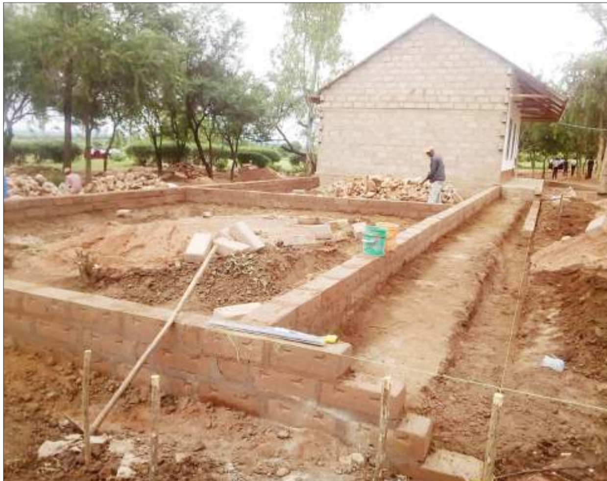
Madarasa mapya kwa ajili ya wanafunzi wa kidato cha kwanza katika Shule za Sekondari za Kata, Jimbo la Musesa Viji-jini mkoani Mara, yanaendelea kujengwa ili kuhakikisha wanaanza masomo haraka iwezekanavyo. Huu ni msingi wa moja ya madarasa yanayojengwa katika Shule ya Sekondari Nyambono. PICHA: OFISI YA MBUNGE
