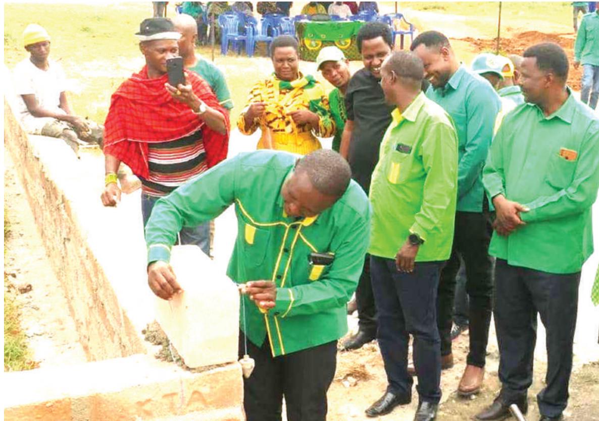
Mwenyekiti wa CCM Wilaya ya Simanjiro mkoani Manyara, Kiria Laizer (kulia), akiweka tofali kwenye ukuta katika ujenzi wa ofisi mpya za CCM Kata ya Orkesumet, alipotembelea na kamati ya siasa ya wilaya juzi.
