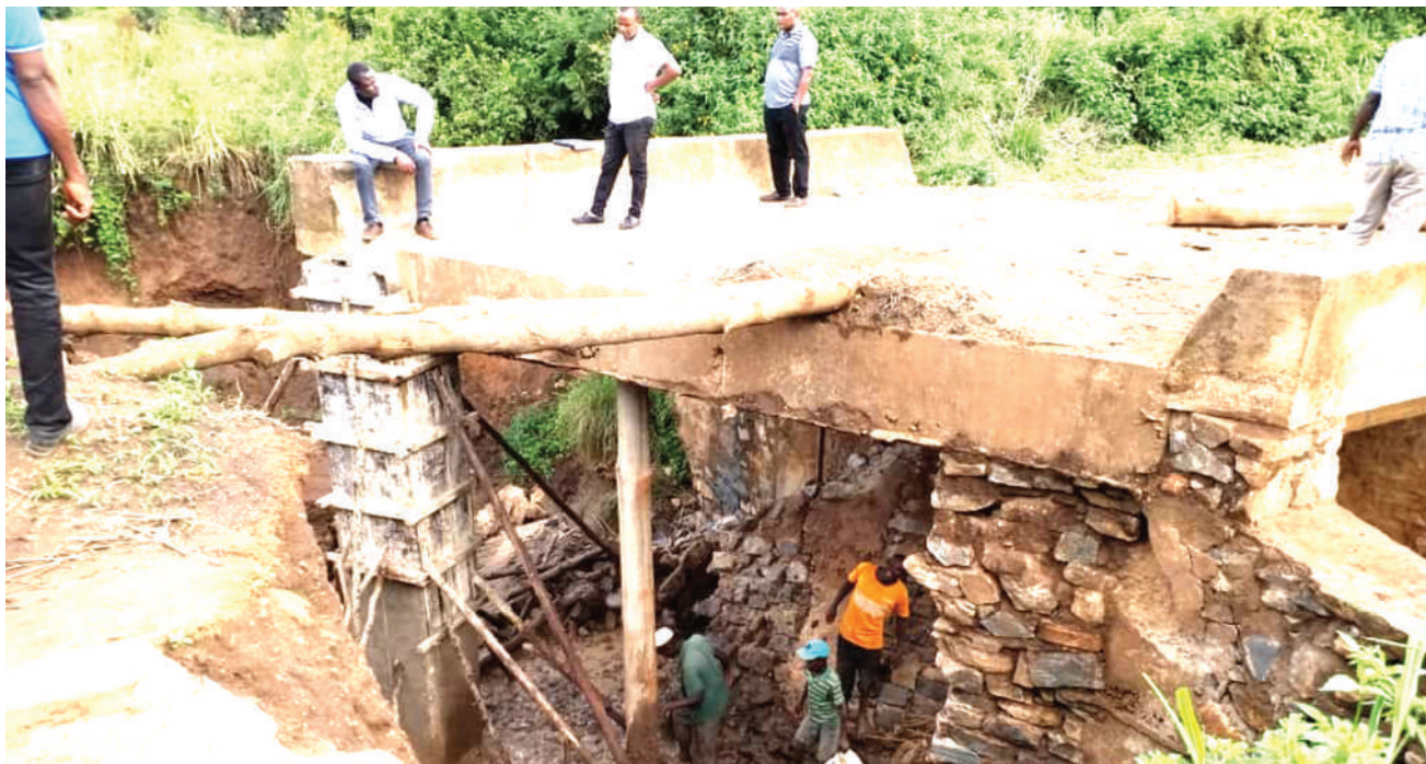
Mafundi waliopewa kandarasi ya ujenzi wa daraja linalounganisha Kata Kisiwani/Msindo, Wilayani Same, mkoani Kilimanjaro, wakiendelea na kazi ya kilijenga daraja hilo lililosombwa na maji jana. PICHA: GODFREY MUSHI
