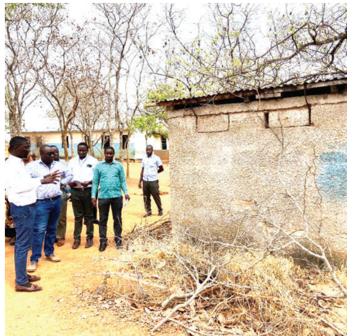
Mwalimu Mkuu wa Shule ya Msingi Nyanhembe Clement Nelson (wa kwanza kulia), akionyesha choo kilichokuwa kikitumiwa na wanafunzi wa kiume awali shuleni hapo.
