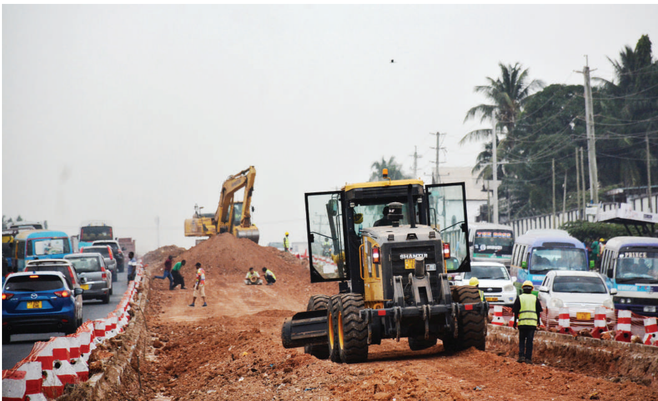
Kazi ya ujenzi wa barabara ya mabasi ya mwendokasi ikiendelea katika barabara ya Bagamoyo eneo la Afrikana, jijini Dar es Salaam jana. PICHA: MIRAJI MSALA
