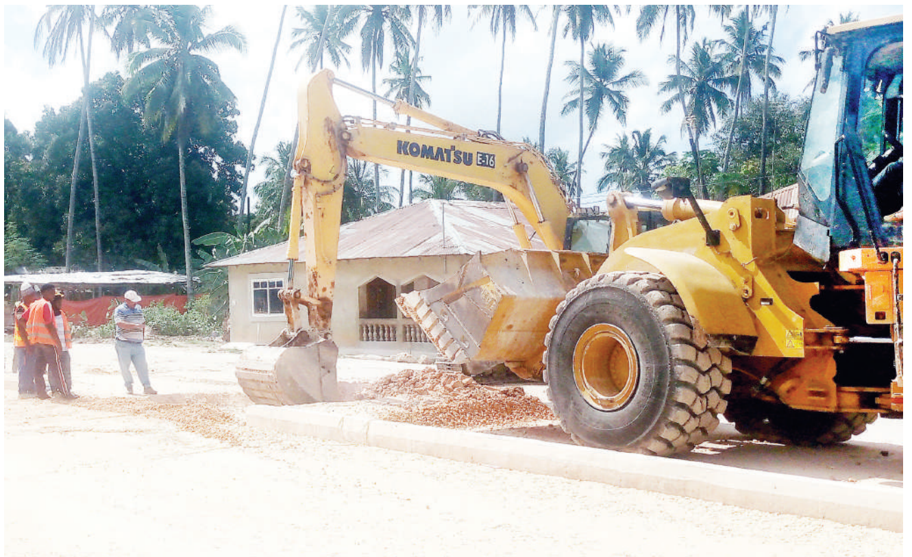
Mafundi wakiendelea na ujenzi wa barabara kutoka mjini Zanzibar kwenda Mkoa wa Kusini Unguja kwa kiwango chalamu katika eneo la Jumbi, hivi karibuni. PICHA: SABATO KASIKA
