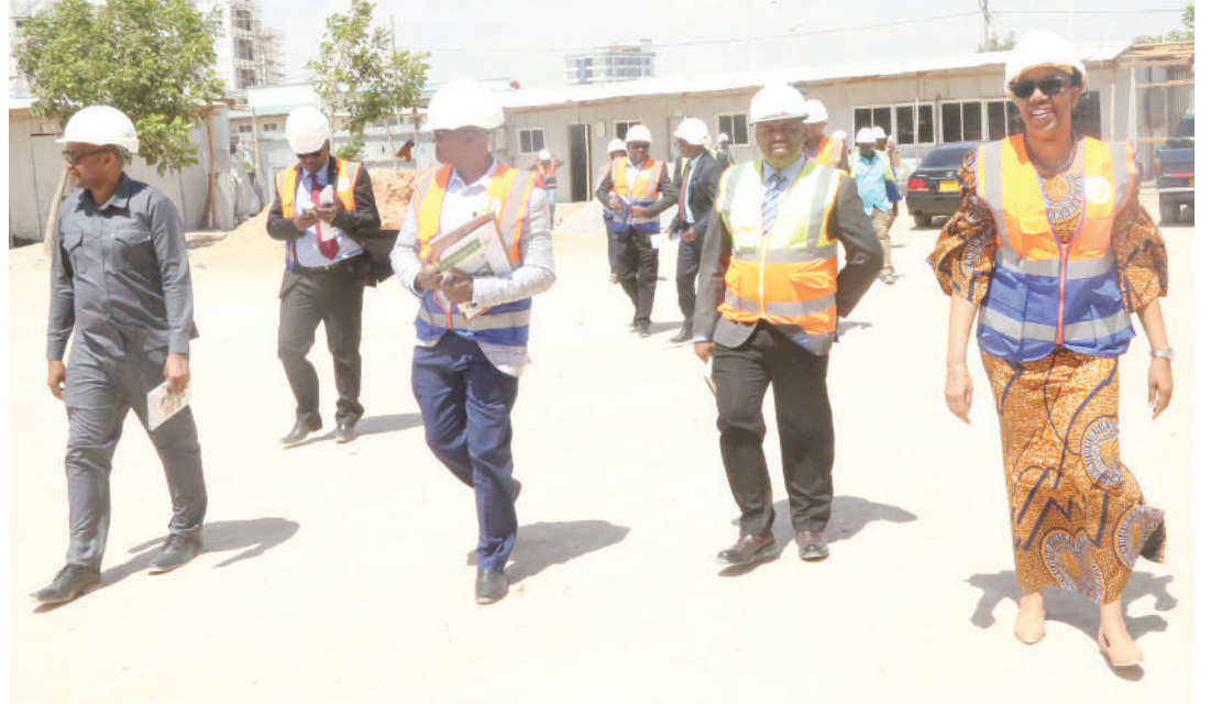
Katibu Mkuu Ofisi ya Makamu wa Rais, Mary Maganga, akiongoza Menejimenti ya Ofisi ya Makamu wa Rais kukagua ujenzi wa jengo la ofisi hiyo unaoendelea katika Mji wa Serikali Mtumba, jijini Dodoma jana. PICHA: OMR
