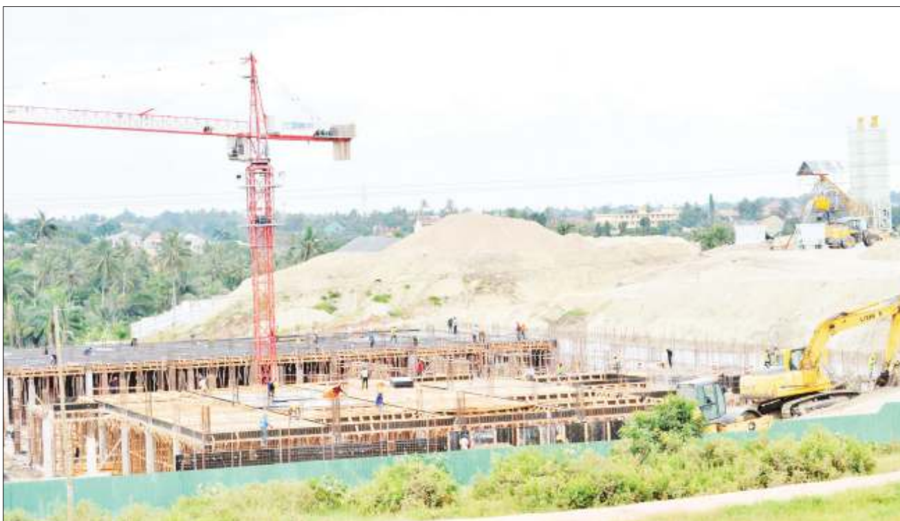
Mafundi wakiendelea na kazi ya ujenzi wa majengo ya ofisi za stedi mpya ya mabasi ya mikoani katika eneo la Mbezi Mwisho, jijini Dar es Salaam jana. PICHA: MIRAJI MSALA
