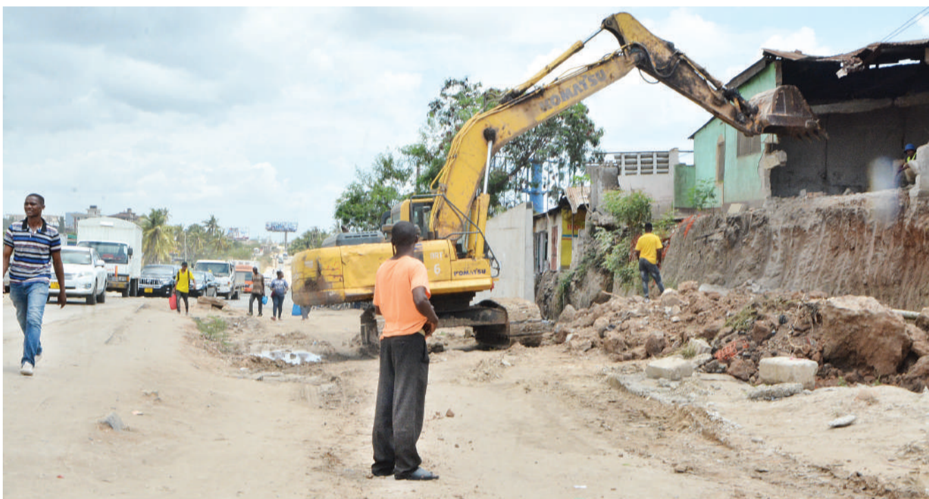
Tingatinga likibomoa nyumba kupisha upanuzi wa Barabara ya Kawawa katika eneo la Msimbazi Centre, Ilala Mchichini, jijini Dar es Salaam mwishoni mwa wiki. PICHA: MIRAJI MSALA
