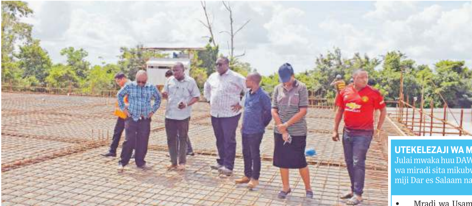
Katibu Mkuu wa Wizara ya Maji Prof. Kitila Mkumbo akikagua ujenzi wa tenki la maji lenye ujazo wa lita milioni 6 litakalohudumia Wilaya ya Kisarawe pamoja na maeneo Pugu, Chanika, Majohe na Gongo la Mboto.
