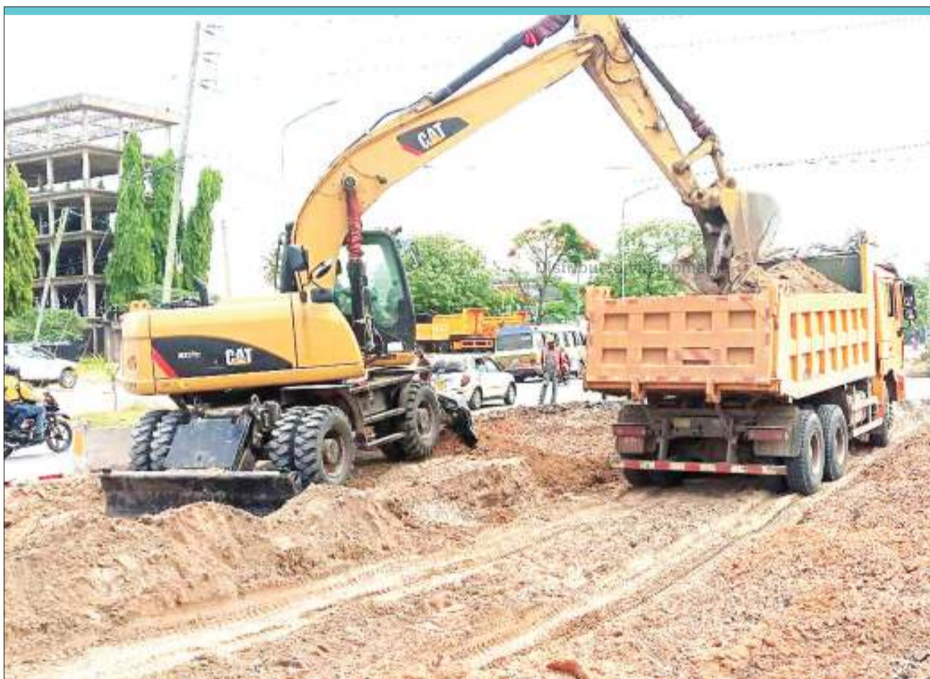
Ujenzi wa barabara ya mwendokasi kutoka Gerezani kwenda Mbagala, jijini Dar es Salaam, inayojengwa na mkandarasi kutoka China ukiteendelea katika Barabara ya Kilwa, eneo la Jitegemee, juzi. Picha: JOSEPH MWENDAPOLE
