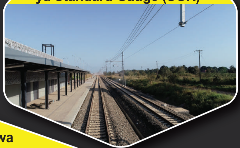
Ujenzi wa reli ya Standard Gauge (SGR)
