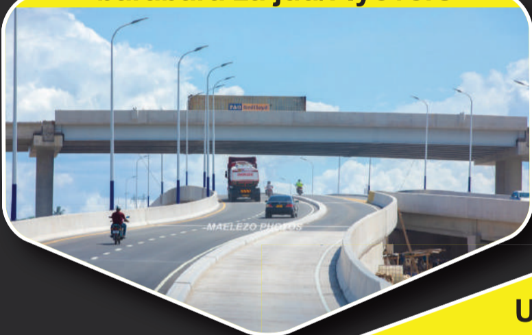
Ujenzi wa barabara za juu/Flyovers
