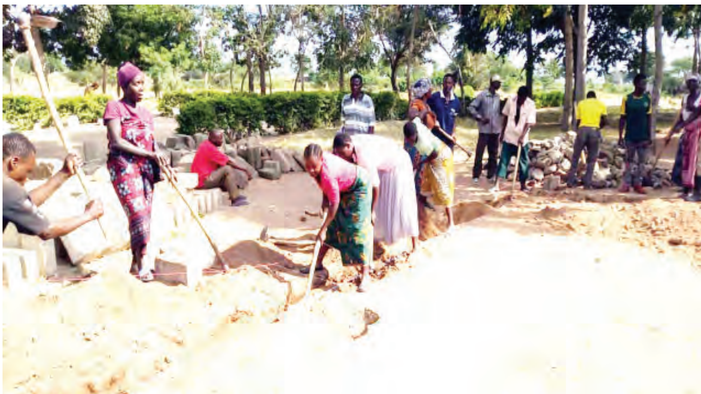
Wanawake wakichimba msingi kwa ajili ya ujenzi wa madarasa ya Shule ya Msingi Karubugu, Kata ya Mugango, wilayani Musoma, mkoani Mara juzi, ikiwa ni kuchangia nguvu kazi yao katika kazi hiyo. PICHA: MPIGAPICHA WETU
