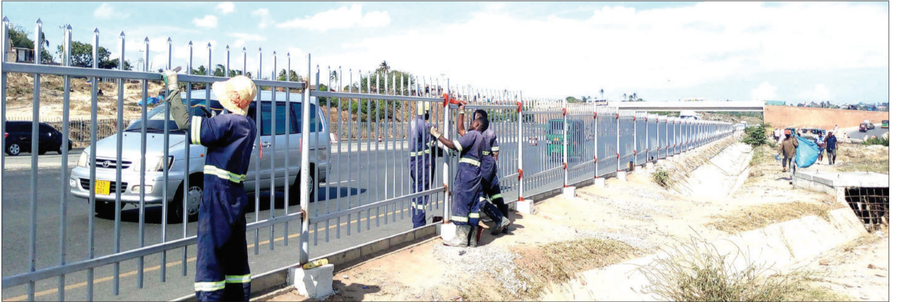
Mafundi wa kampuni ya ujenzi ya Estim wakirekebisha baadhi ya maeneo ya uzio wa barabara ya Morogoro, Mbezi Kwa Yusuph, Manispaa ya Ubungo Dar es Salaam jana. PICHA: SABATO KASIKA
