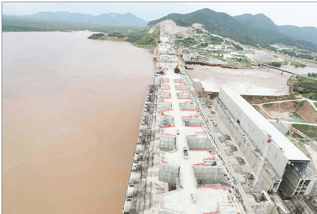
Bwawa la maji la Grand Renaissance likiwa katika hatua ya ujenzi.
