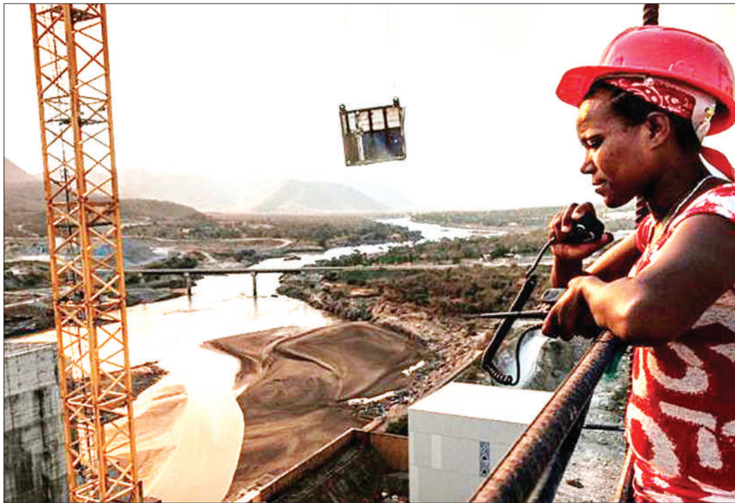
Mfanyakazi wa ujenzi katika bwawa la Grand Renaissance, akiungalia Mto Nile unaotumika kujaza maji.
