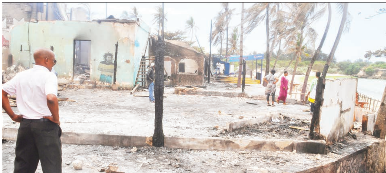
Mkazi wa Jiji la Dar es Salaam, akiangalia sehemu ya mabaki ya hoteli ya Coco Beach, jijini humo jana, baada ya kuteketea kwa moto, juzi. PICHA: JOHN BADI
