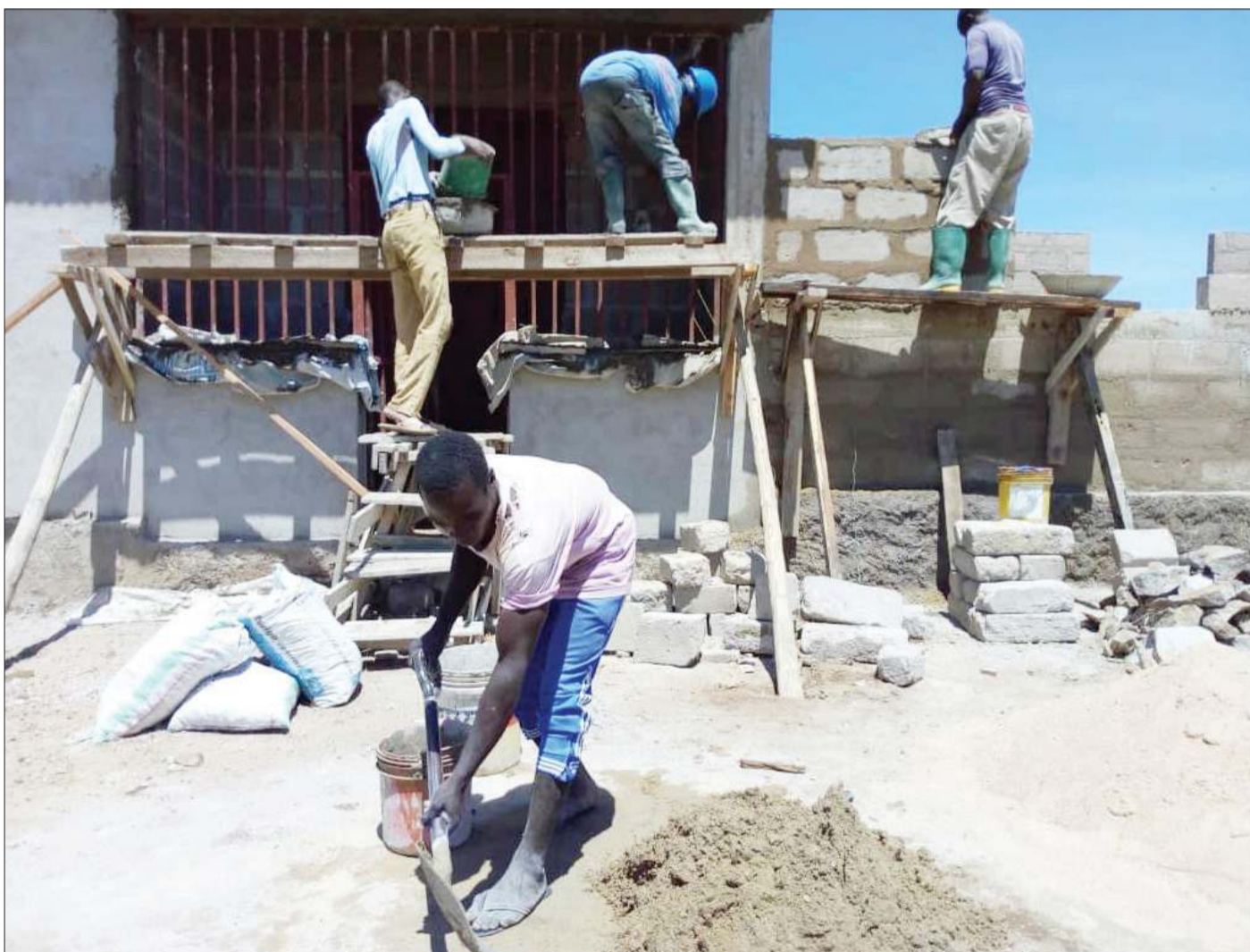
Mafundi wakijenga jengo la maabara ya kisasa ya huduma za afya ya Kanisa Katoliki, Parokia ya Bukima, Musoma Vijijini, mkoani Mara juji, ili kuwapunguzia wananchi usumbufu wa kusafiri umbali mrefu kufuata huduma hiyo. PICHA: MPIGA PICHA WETU
