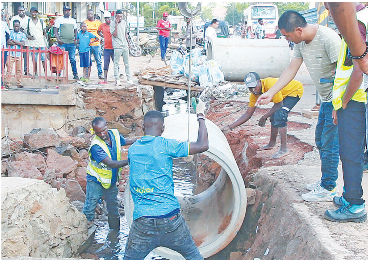
Mkandarasi wa ujenzi wa mradi wa barabara wa uboreshaji wa miundombinu ya miji Tanzania (TACTIC) katika Halmashauri ya Manispaa ya Kahama mkoani Shinyanga, akiendelea na ujenzi wa mitaro ili kuzuia maji kutuama na kuingia katika makazi ya wananchi na kusababisha mafuriko katika mtaa wa Nyasubi jana. PICHA; SHABAN NJIA
