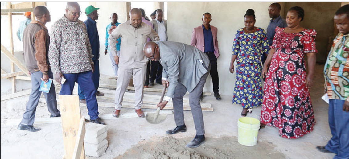
Mkuu wa Mkoa wa Tabora, Dk. Philemon Sengati, akichanganya zege la ujenzi wa bwalo la Shule ya Sekondari ya Mwanhala wakati wa ziara yake wilayani Nzega ya kukagua miradi ya maendeleo jana.
