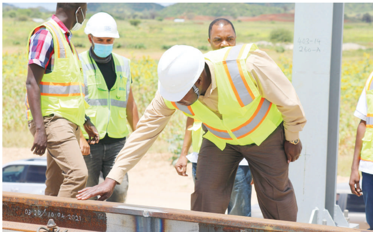
Naibu Waziri wa Ujenzi na Uchukuzi, Mwita Waitara, akiangalia sehemu ya mataruma iliyoungwa katika reli ya kisasa ya SGR, sehemu ya Makutupora hadi Morogoro, wilayani Kilosa, mkoani Morogoro, alipokagua maendeleo ya ujenzi wake, mwishoni mwa wiki. NA MPIGAPICHA WETU
