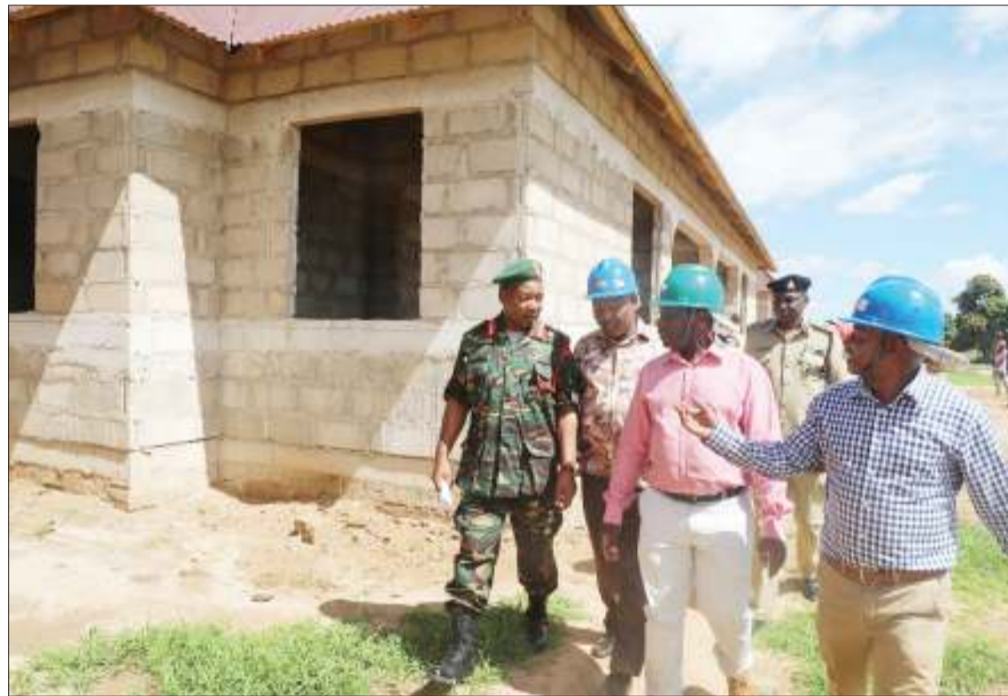
Katibu Mkuu Wizara ya Mambo ya Ndani wa Nchi, Meja Jenerali Jacob Kingu (kushoto), akiongozana na wajumbe wa Kamati ya Kudumu ya Bunge Mambo ya Nje, Ulinzi na Usalama, walipotembelea eneo la Medeli, jijini Dodoma, zinapojengwa nyumba 100, kwa ajili ya makazi ya askari polisi. PICHA: WMN
